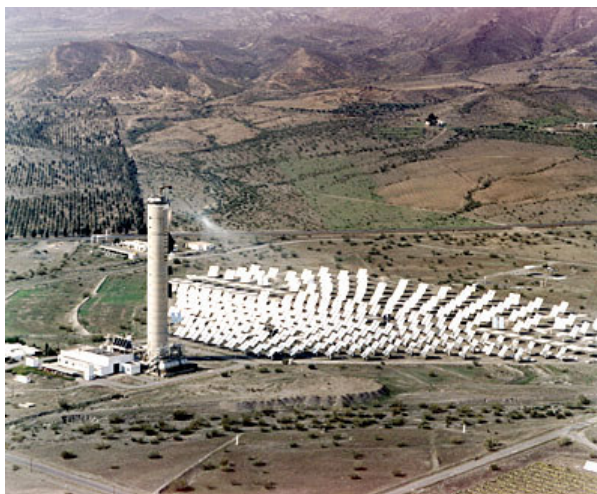
Fig. 3.4.1 – Vista de instalação do tipo Heliostatos e Torre Central
