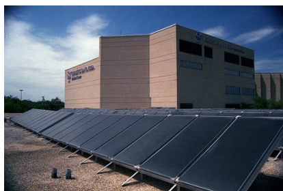
Fig. 3.1.2 – Planta comercial utilizando coletores tipo Placa Plana
